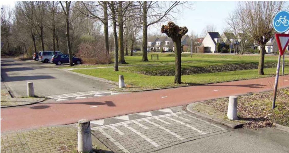
Kuva 3 Autolla on kärkeä osoitettu väistämismäärä Groningenissa, kun tonttikatu risteää pyöräilyn pääväylän kanssa. Liikenneympäristö on lisäksi korotettu ja kavennettu, jotta autoilija hiljentää vauhtiaan (Vaismaa et al. 2011, 154).
